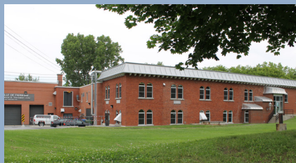
Station de traitement d'eau potable 777, rue Principale Est Farnham (Québec) J2N 1M2 Téléphone : 450 293-3326, poste 301
