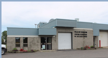
Station d'épuration des eaux usées 901, rue Lucien-Chénier Farnham (Québec) J2N 0A9 Téléphone : 450 337-3007
