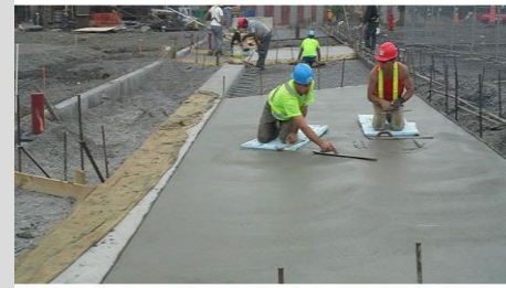
4 Ouvrage en béton
