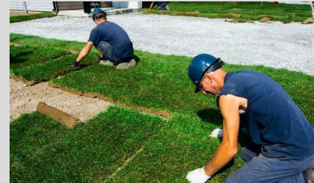
6 Réparation des surfaces
